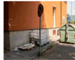
Degrado Nella parte posteriore del complesso
