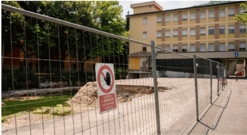
Lavori in corso Uno dei cantieri presenti all'interno del cortile dell'ospedale di Marzana FOTOSERVIZIO MARCHIORI
